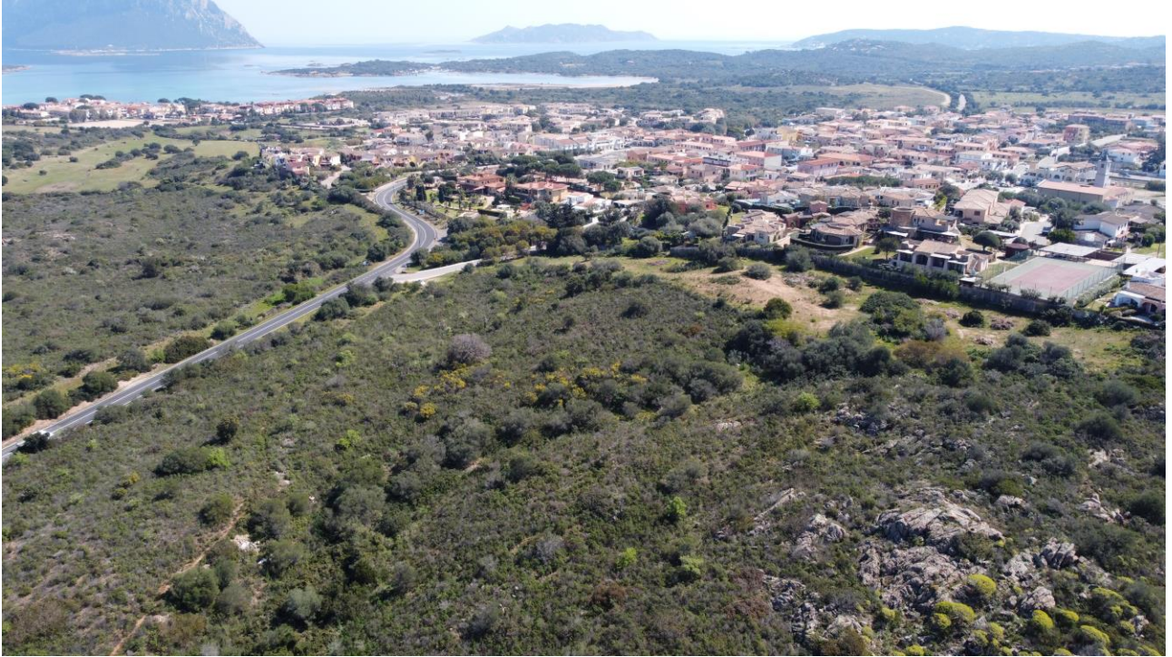
Foto n° 5. Vista da nord- ovest
