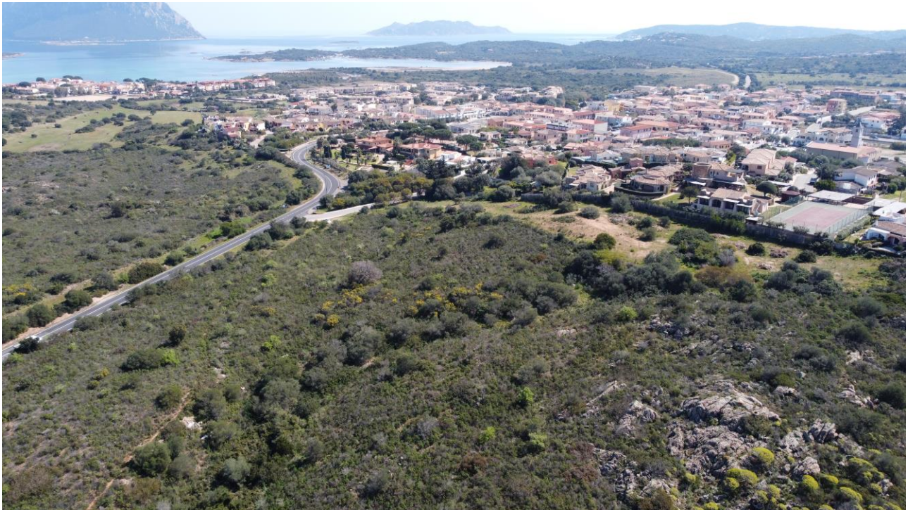
Foto n° 5. Vista da nord- ovest
