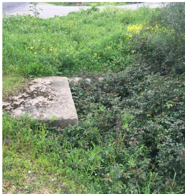
Figura 5 - Particolare del punto di ingresso al tombino stradale (sezione di monte)
