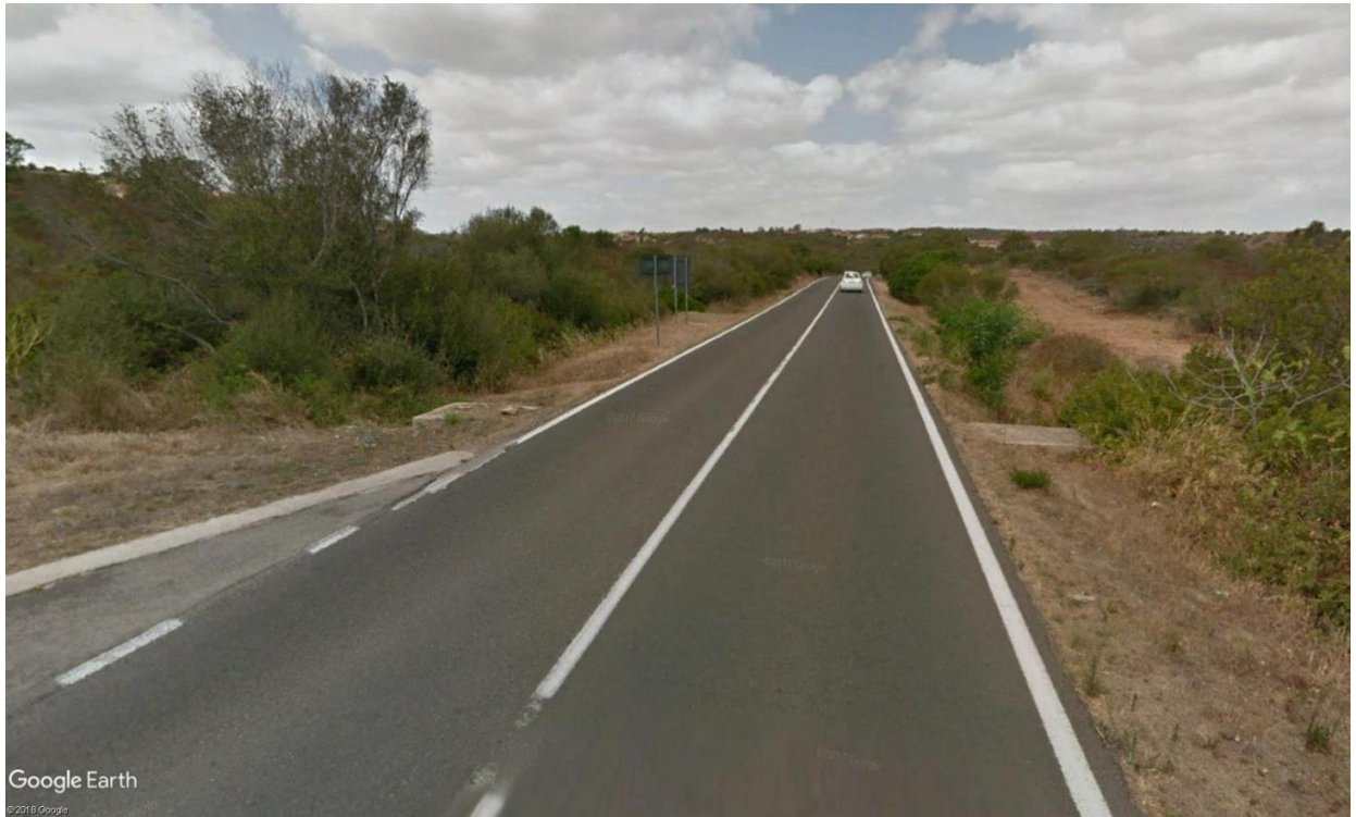
Figura 4 - Tratto stradale sulla S.S. 125 attraversato dal tombino
