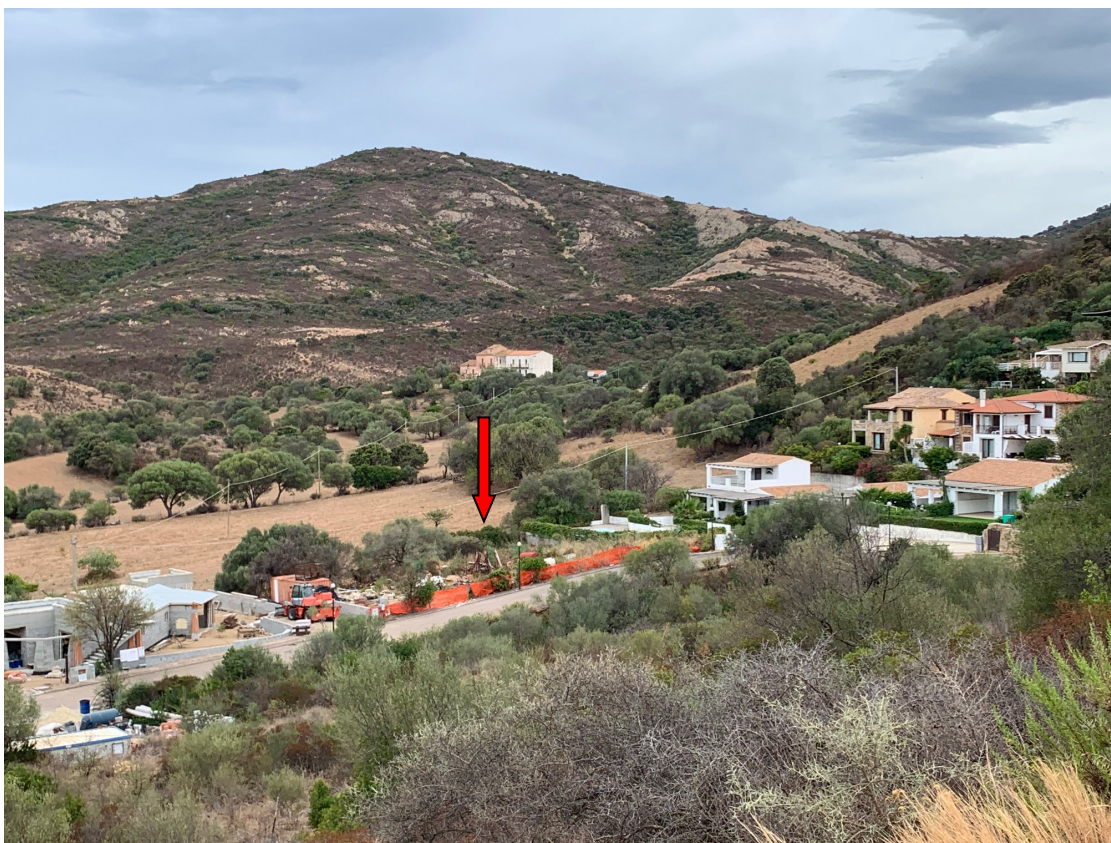
VISTA AREA CON INDICAZIONE INTERVENTO
